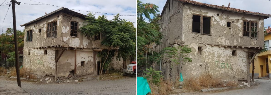
Şekil 5.4.2.4. Saray Mahallesi 7 Ada 10 Parselde Bulunan Yapı (Kaynak, 5. Grup Kalecik Atelyesi Öğrencileri, 2020)
