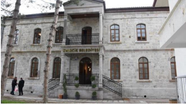
Şekil 5.4.1.1.1.1 Kalecik Belediye Binası (Kaynak, URL-51)
