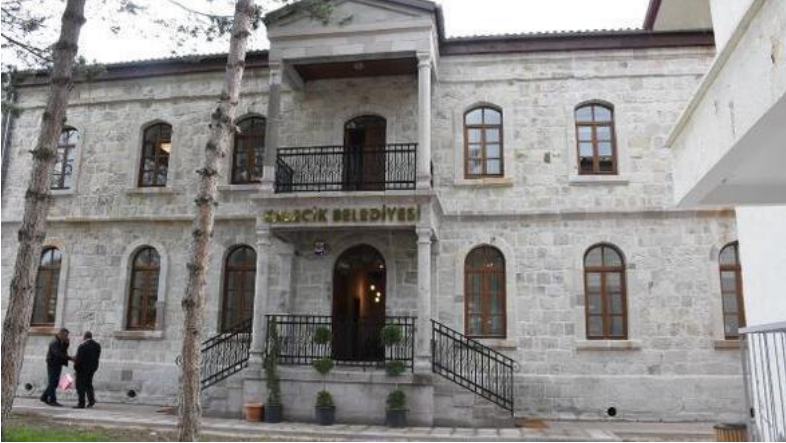
Şekil 5.6.4.2. Kalecik Belediye Binası (Kaynak, URL-66)
