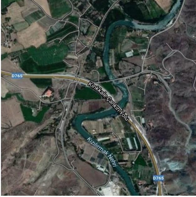
Şekil 7.4.6.5. Develioğlu Köprüsü (Kaynak , URL-141)
