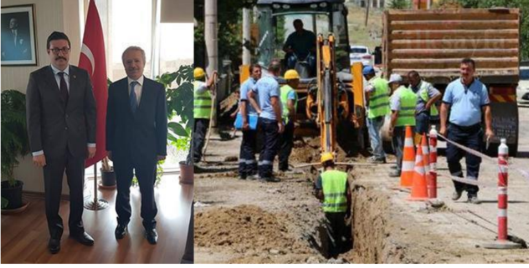
Şekil 7.4.3.3. Kalecik ilçesinde başlanılan doğalgaz çalışmaları. (Kaynak , URL-133)
