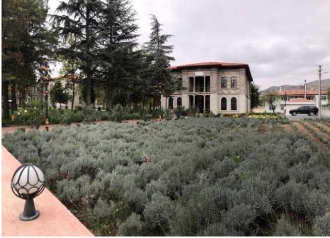
Şekil 5.4.1.1.5.1 Belediye Binası Yanındaki Taş Bina (Kaynak,5. Grup Kalecik Atelyesi Öğrencileri, 2020 )
