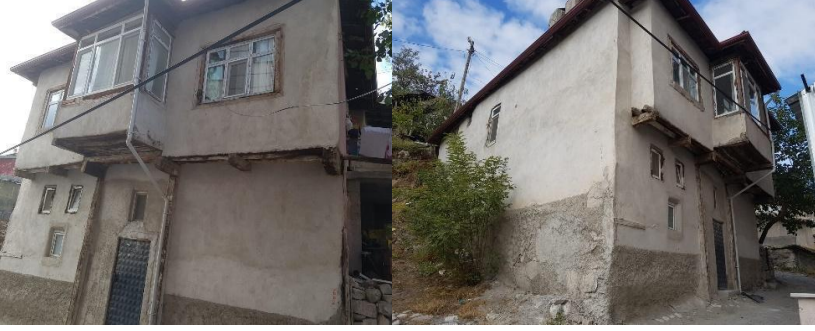
Şekil 5.4.2.5. Cuma Mahallesi 28 Ada 6 Parselde Bulunan Yapı (Kaynak, 5. Grup Kalecik Atelyesi Öğrencileri, 2020)
