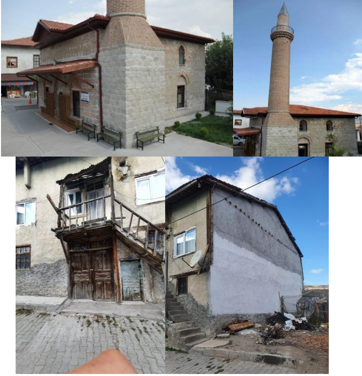
Şekil 5.4.2.9 Saray Mahallesi 8 Ada 21 Parselde Bulunan Yapı (Kaynak, 5. Grup Kalecik Atelyesi Öğrencileri, 2020)
