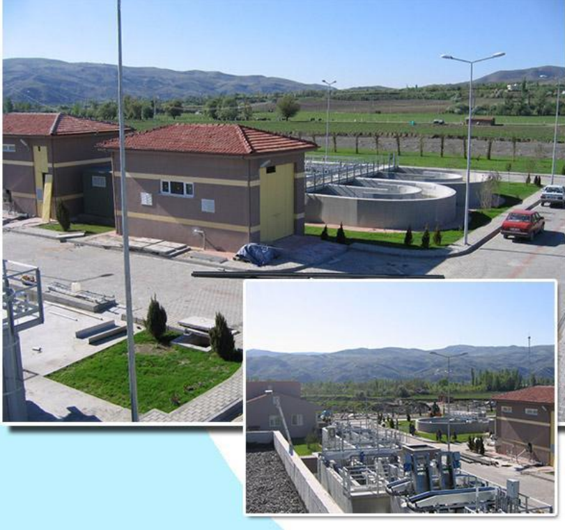
Şekil 7.4.2.3.1. Kalecik Atık Su Arıtma Tesisi (Kaynak , URL- 128)
