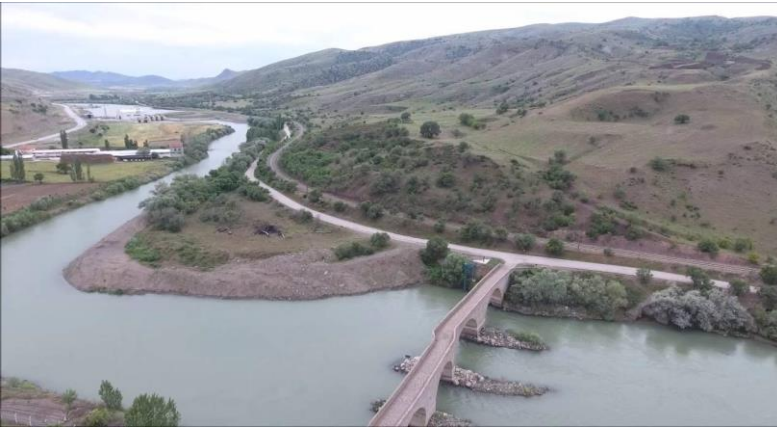
Şekil 7.5.1.1. Develioğlu köprüsü (Kaynak , URL- 142)
