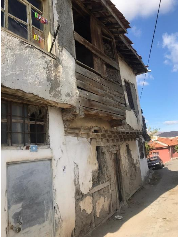
Şekil 5.4.2.7. Halılağa Mahallesi 308 Ada 6 Parsel Mahallesinde bulunan Yapı (Kaynak, 5. Grup Kalecik Atelyesi Öğrencileri, 2020)
