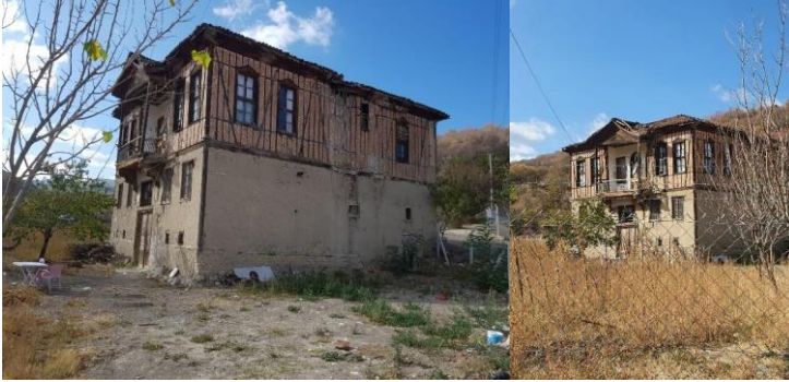
Şekil 5.4.2.10 Yeşilyurt Mahallesi 433 Ada 10 Parselde Bulunan Yapı (Kaynak, 5. Grup Kalecik Atelyesi Öğrencileri, 2020)
