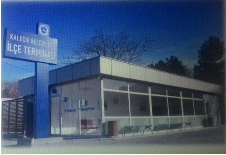
Şekil 7.3.1.1. Yapımı yeni biten Kalecik İlçe Terminali ( Kaynak , URL-100)
